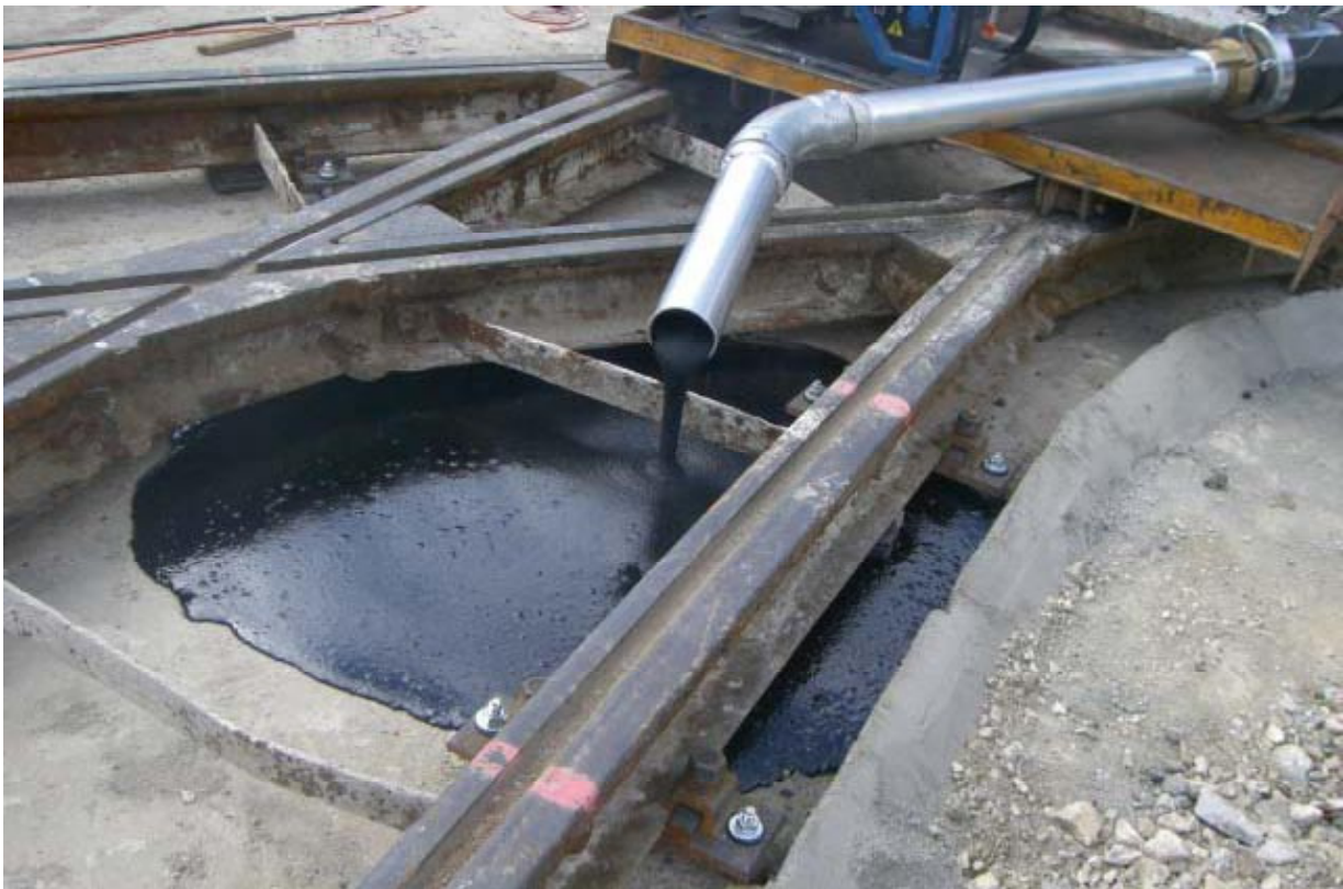
Bild 12. Utläggning av gjutasfalt mellan räls för spårvagnar [Magazin 03].
