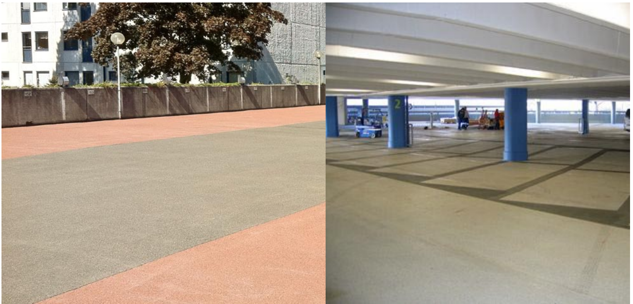
Bild 15. Infärgad gjutasfalt i Haninge (tv) och Stockholm Arlanda (th).
