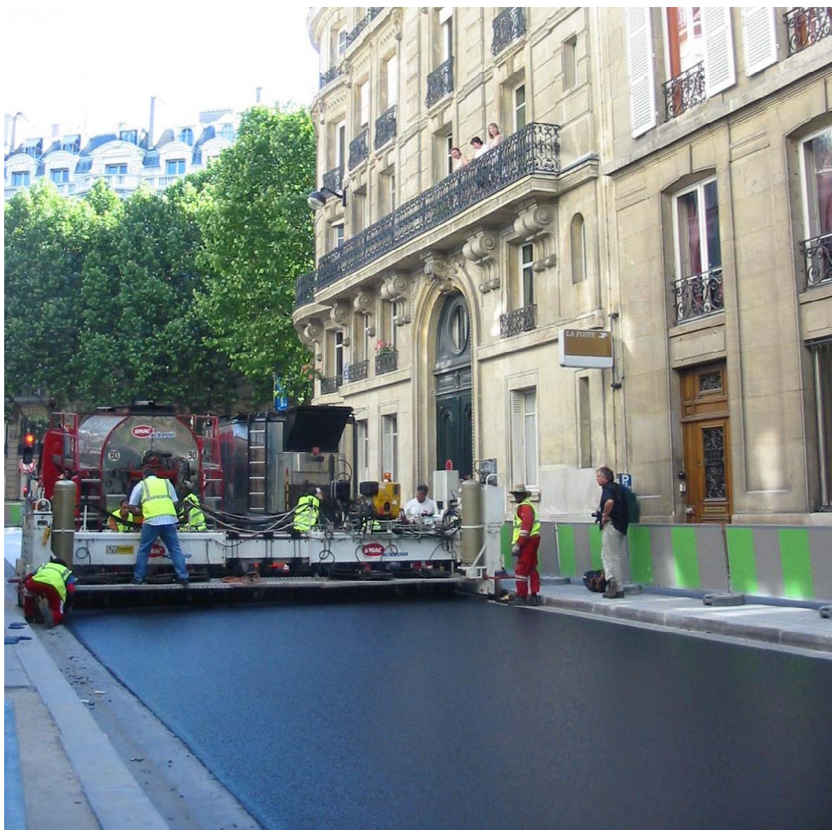
Bild 10. Maskinell utläggning av gjutasfalt på väg/gata [The Mastic Asphalt Industry].
