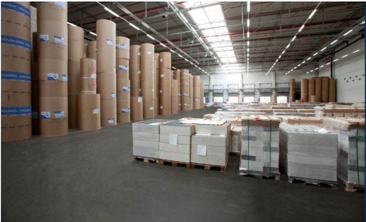
Bild 21. Industrigolv med gjutasfalt [Magazin 02].
