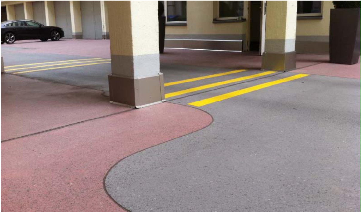
Bild 16. Slipad gjutasfalt med olika färgsättning för kör- och parkeringsytor [Magazin 03].
