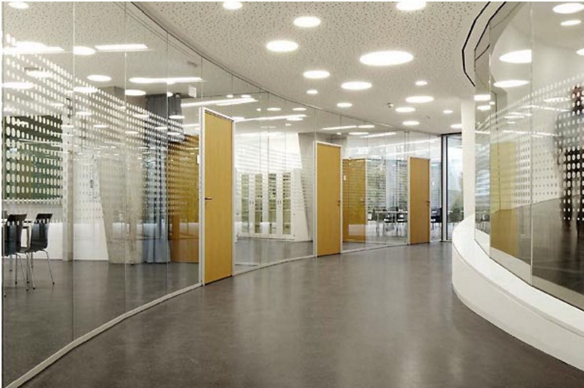
Bild 6. Interiör från Haus der Astronomie. Slipat gjutasfaltgolv.
