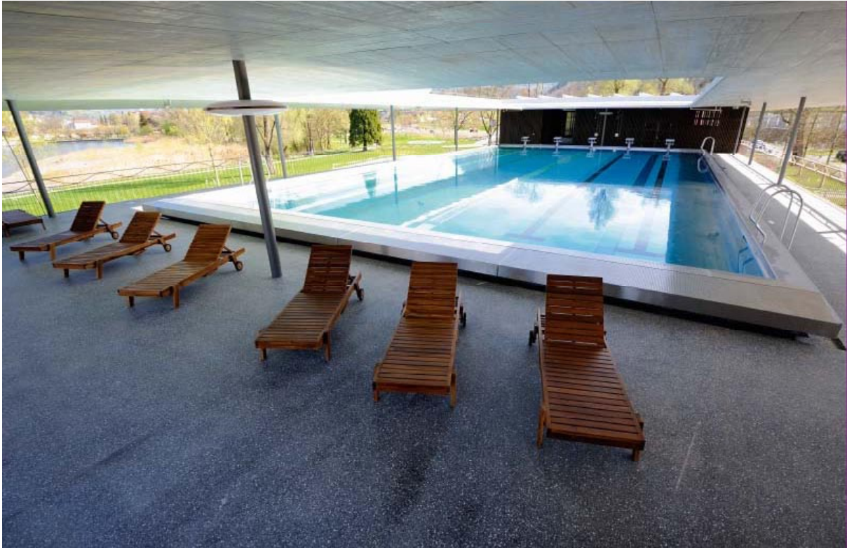
Bild 24. Slipat gjutasfaltgolv kring bassäng i Seefeld Park, anlagd 2010/2011.
