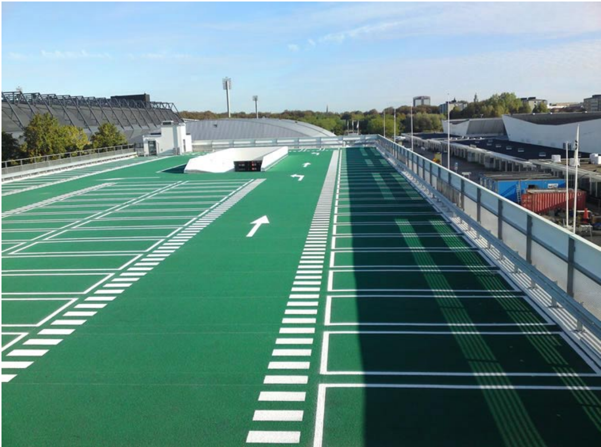
Bild 14. Grön gjutasfalt på parkeringsdäck i Malmö Stadion. Grön keramisk sten har vältats in i gjutasfalten.
