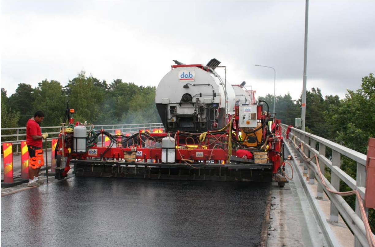
Bild 13. Utläggning av gjutasfalt på betongbro (foto Mikael Kinnmark).
