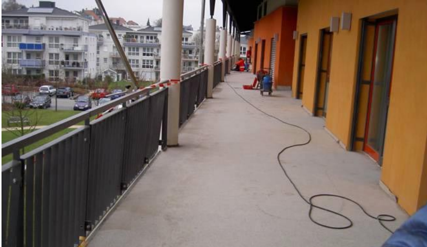
Bild 17. Balkong med gutasfalt.
