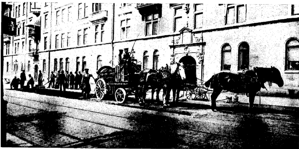
Bild 4. Läggnig av gjutasfalt på Strandvägen 1914 [Dufwa 1985].
